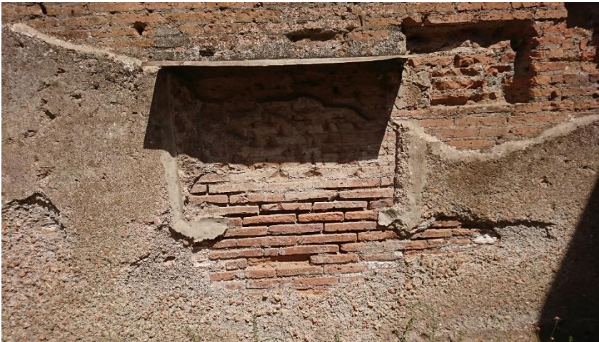
Fig.1 The lost of plaster (Caserma dei Vigili (II, V, 1), 44)
