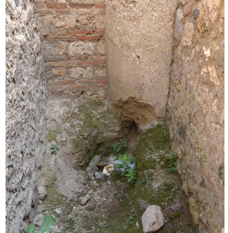
トイレの下部
